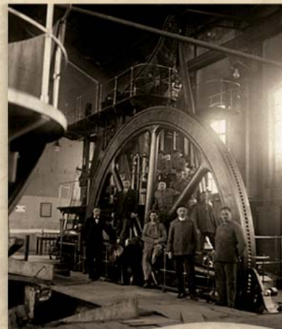
Himbás csatolású, forgattyús, lendkerekes gép (Budaújlak)
