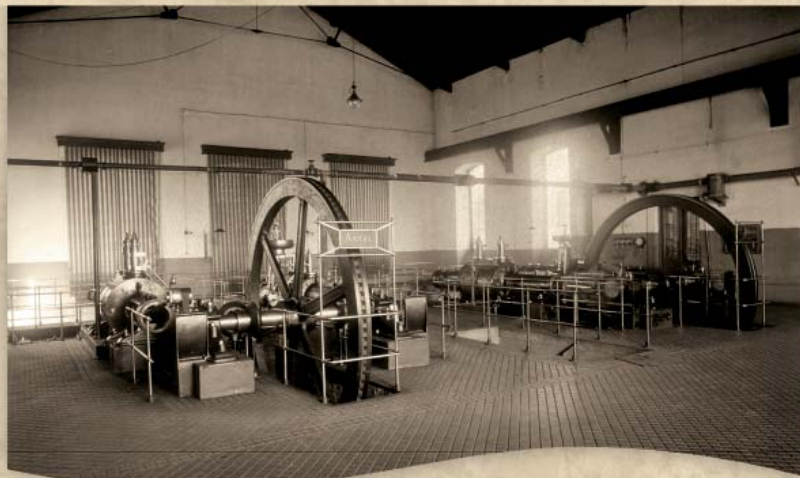
Forgattyús, lendkerekes, közös rudazatú gépegység (I. átemelő 1897)
